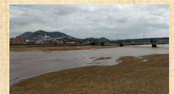
↑ 黒瀬川で撮った写真 Normal 92%と判別された。
